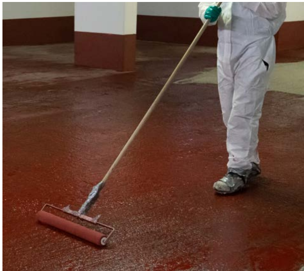
Abb. 6 Verteilen des Harzes mit langstieligen Werkzeugen
